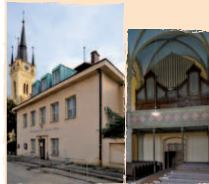
KOSTEL A FARA
